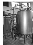
Hôpital thermal de Dax (40) Réalisation Pierre Guérin et T.T.I.A.G
